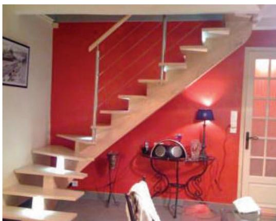
**Authenticité & originalité** : câbles ou lisses inox, découvrez nos possibilités... L'escalier sur limon central est incontournable et intemporel. Qu'il soit droit, 1/4 tournant, 2/4 tournant ou en courbe, sa colonne vertébrale souvent rectangulaire ou ronde donne des lignes fluides. Il sera en parfaite harmonie avec votre intérieur.
